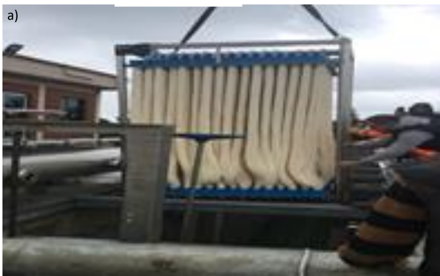
Fig. 3. UF membranes: (a) Hollow fiber – MEMSIS, (b) Flat sheet – MDN.
